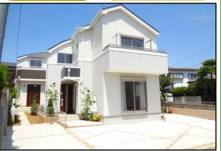
1階リビング・堂々完成
